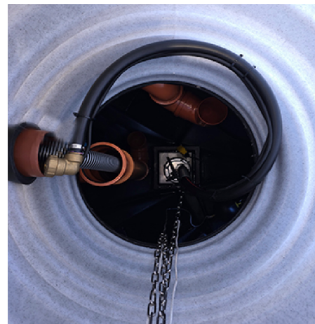
Pumpeslange i opføringsrør
